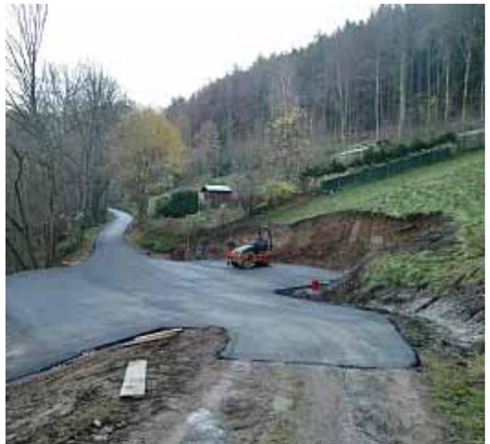
Die Vorfläche vor dem Portalbauwerk beim „Salomonweg“ und der Abfuhrweg für das Ausbruchmaterial in Richtung Schmelzegrün wurden hergerichtet und bituminös befestigt.
