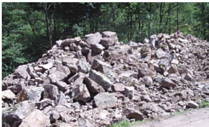
Größte Herausforderung bei der Maßnahme ist der Umgang mit den ständig und immer wieder zu Tage tretenden großen Granitsteinen, die zum Teil die Größe von einem Kleinwagen haben. Insgesamt wurden bisher ca. 3.500 to an Steinen abgefahren und auf einem Lagerplatz zerkleinert, gebrochen und später wieder eingebaut. Diese Vorgehensweise ist erheblich günstiger als die Steine auf eine Deponie zu fahren und später angekauft Material wieder einzubauen.
