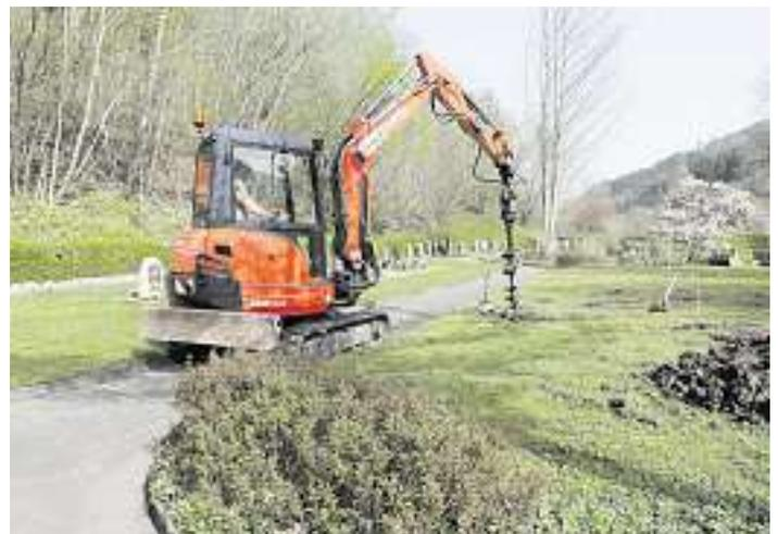
Mit einem Erdbohrer wird die Einbringung der Edelstahl-Erdröhren vorbereitet
