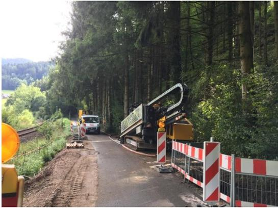
Die Firma Lienhard aus Waldshut-Tiengen führte ab 24. August 2020 das Horizontalspülbohrverfahren in einer Länge von etwa 450 Meter durch.
