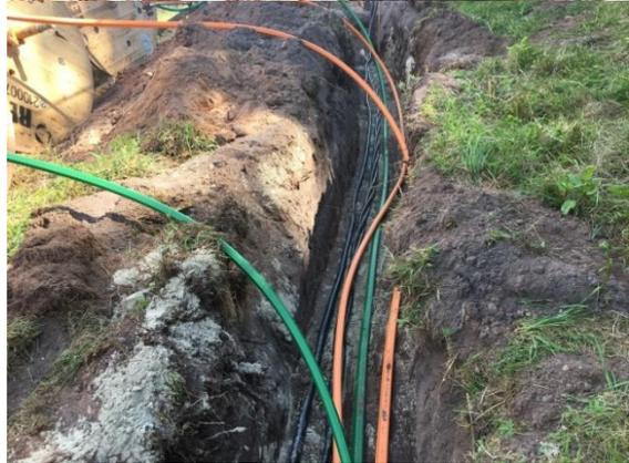
Verlegung der Strom- und Glasfaserleitungen im Seitenstreifen durch die Fa. Horn.
