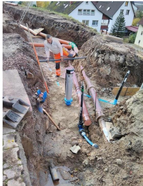
*Komplexes Leitungssystem – die Erneuerung der Wasserleitung „Auf der Kanzel“ im Umfang von knapp 40.000,00 € wurde im Jahr 2020 fertig gestellt. Im Bild Bauhofmitarbeiter Michael Maier, der bei Bedarf das Team der Wasserversorgung unterstützt.*
