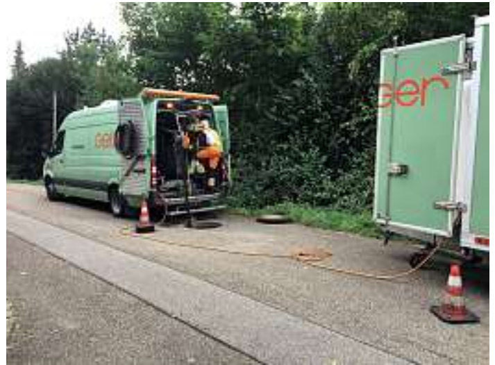
Firma Geiger bei der Kanalsanierung im Schlössleweg mit Robotertechnik
