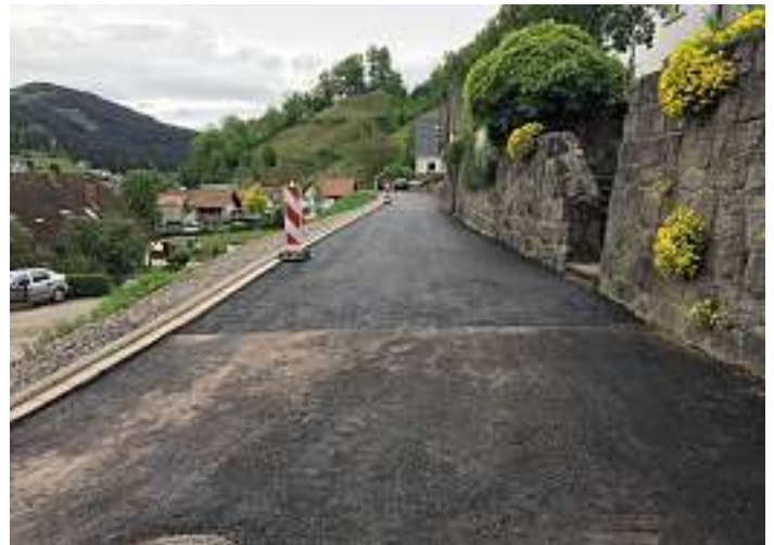
Straßenbau und Erneuerung der Ver- und Entsorgungsleitungen „Auf der Kanzel“
