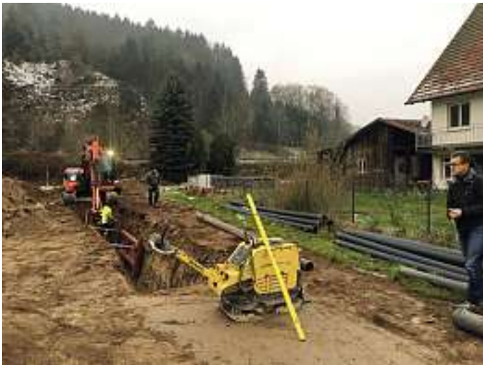
Aufweitung des Schmutzwasserkanals Zwischen Radweg und Bahnlinie durch die Firma Kala-Erdbau
