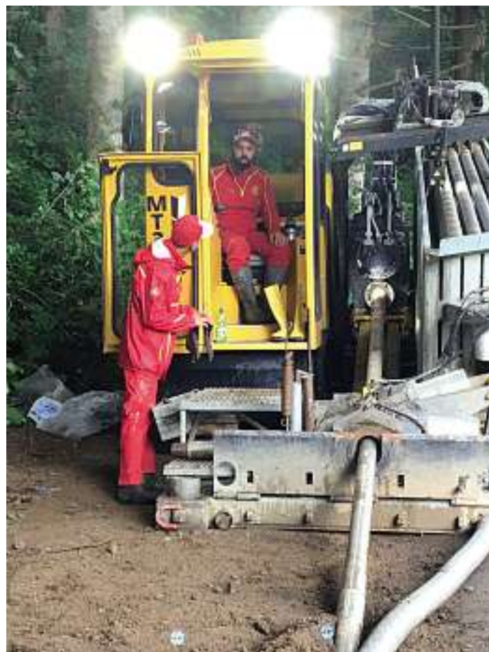
Bohrmaschine welche ein Hohlraum mit 400 mm durch die Erde und Fels gebohrt hat
