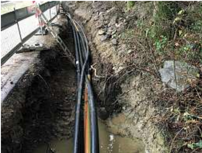
Startgrube mit den eingezogenen Leerrohren und Abwasserdruckleitung am Radweg
