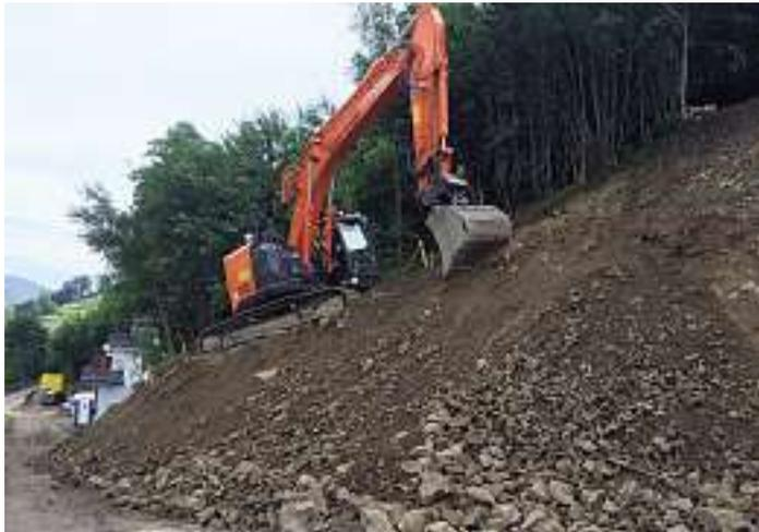
*Aufschüttung einer Rampe als Auffahrtshilfe zur Ausarbeitung der Böschung des Wendehammers*
