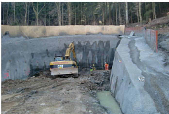
*Der Tunnelseinschnitt in den Hang bedurfte erheblicher Erdabtragungen und Sicherungsmaßnahmen mit Spritzbeton.*
