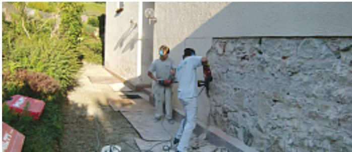
Zunächst haben die Arbeiter an der Außenfassade den Schadputz großflächig abgeschlagen.
