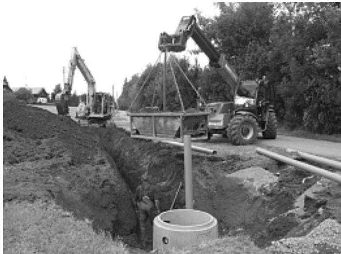
*Verlegen des Pumpenschachtes auf dem Moosenmättle – schweres Gerät ist zur Leitungsverlegung unentbehrlich ...*
