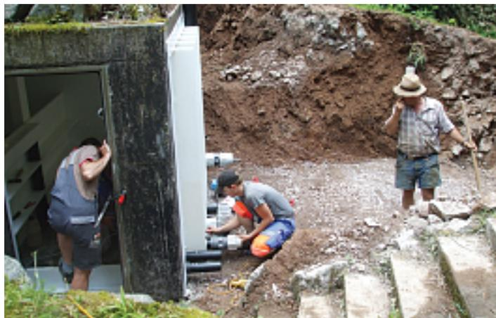
Im Anschluss wurde der von der Firma Drescher aus Löfingen vorgefertigte PE-Behälter durch die Öffnung in den Quellsammelschacht eingeschoben. Diese Vorgehensweise
