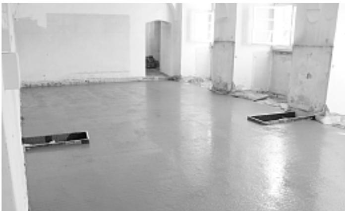
Wo vorher noch ein Loch war, glänzt nun der frische Beton. Nach einer kurzen Trocknungszeit von 24 Stunden kann mit dem Aufbau der Ausstellung „Der Baum“ begonnen werden. Seitlich in den Aussparungen sind zwei alte Mauersockel einer früheren Trennwand erhalten.
