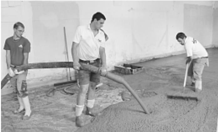
Mit dem Einbau des Betonfußbodens wurde der erste Bauabschnitt bei der Museumssanierung am vergangenen Donnerstag abgeschlossen. Innerhalb kürzester Zeit beförderte eine mächtige Pumpe über 20 Kubikmeter Beton aus dem Bauch von drei großen Betontransportern ins Innere des alten Fürstenberger Schlosses.
