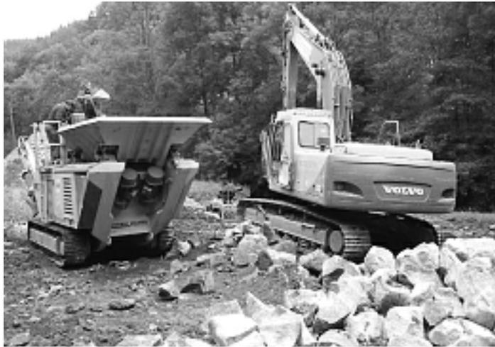
So werden unter anderem die vielen Steine und Felsbrocken, die bei der Maßnahme erwartet werden, „gebroschen“ und anschließend als Verfüllmaterial im Leitungsgraben wieder eingebaut. Außerdem verlegt die Abwassergemeinschaft im Verlauf der Hauptleitung die 20 KV-Leitung des E-Werks Mittelbaden mit in die Kanaltrasse, so dass in den nächsten Jahren viele Strommasten auf den jeweiligen Grundstücken abgebaut werden können.
