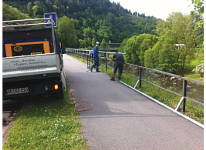
Das bestehende Geländer wurde im Vorfeld ausgerichtet und nun eine Erhöhung von bis zu 50 cm aufgeschweißt. Nach der Erhöhung wird vom Bauhof ein neuer Anstrich aufgebracht, damit das Geländer wieder einen neuen Schutz und eine einheitliche Ansicht hat.
