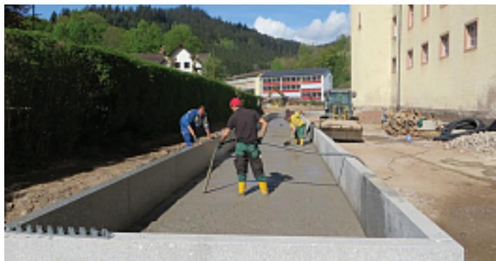
*Die Teichumfassungen wurden in den Schlossanlagen von der Baufirma Grafmüller errichtet, der Boden der Teiche betoniert.*
