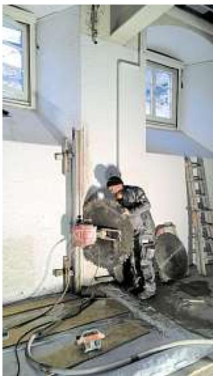
Mit einer großen Kreissäge hatte die Fa. BTS aus Schiltach Schnitte durch die 1,20 m dicken Mauern unter drei Fenstern gesetzt. Dort entstehen zusätzliche Zugänge zum Schlosshof.
