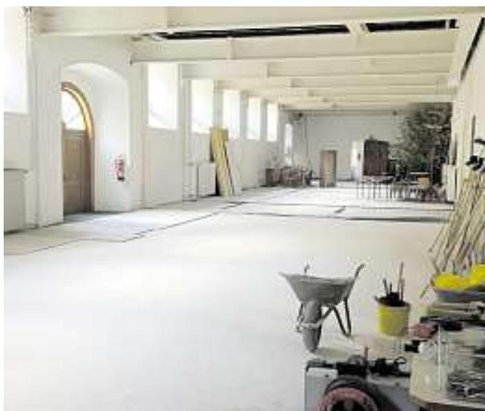
*Die Trennwände und die Schallschutzdecke wurden entfernt. Die Schlosshalle hat jetzt wieder ihre ursprüngliche Länge von 38 m.*
