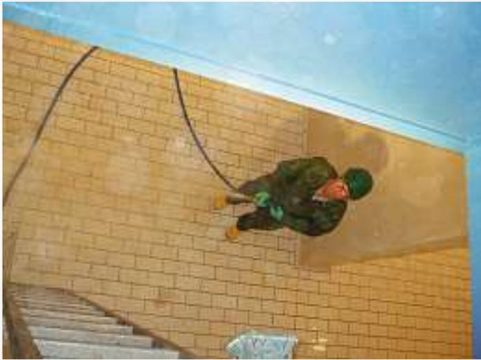
Wassermeister Hubert Decker bei der Nachreinigung eines Hochbehälters nach den Sanierungsarbeiten.
