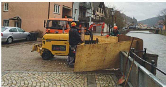
Dabei kam eine selbstfahrende Wurzelstockfräse in Einsatz, welche den Wurzelstock bis auf 60 cm Tiefe ausgearbeitet hat.
