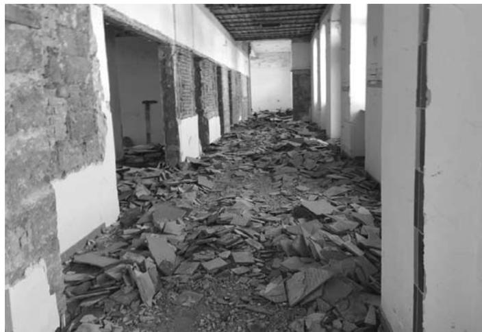
*Das Bild lässt erahnen, wie schwierig und arbeitsintensiv das zuletzt vorgenommene Ausbrechen der Bodenbeläge und des Gussasphaltestrichs im Erdgeschoss war. Dabei musste sogar ein Kleinbagger zum Einsatz kommen. Viele fleißige Hände hatten anschließend das Ausbruchmaterial ins Freie bzw. die Abfallcontainer zu befördern.*
